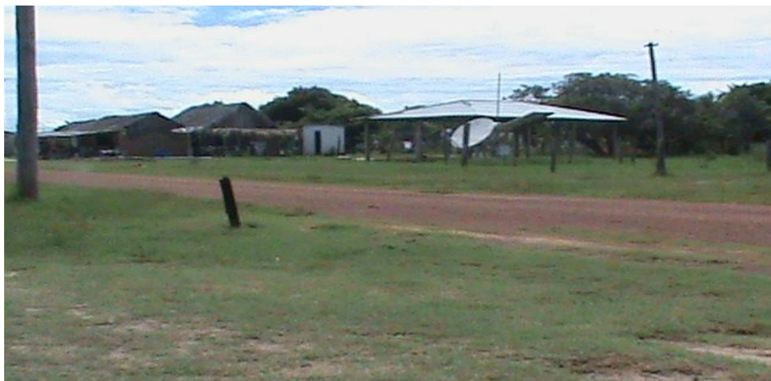
Figura 05 - Antenas do GESAC e de telefonia
